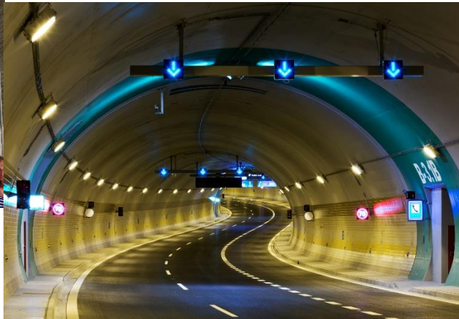
Obr. 22 - Tunelový komplex Blanka
