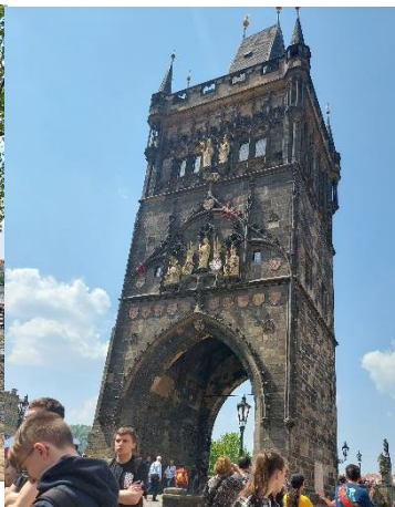
Obr. 29 - veža za Karlovým mostom
