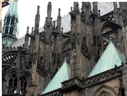
Obr. 9 - Oporný systém katedrály
